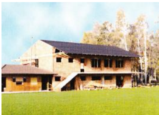
Abb. 35: Das neue Vereinsheim im Rohbau (Rückseite)
