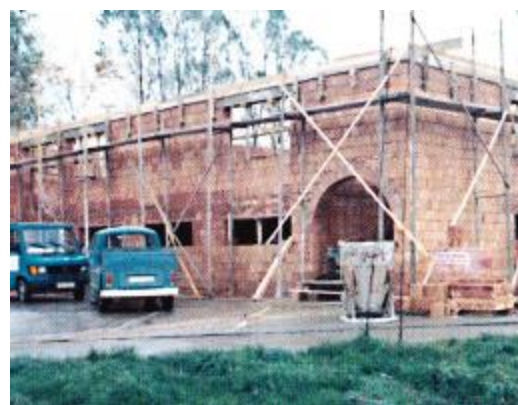
Abb. 34: Das neue Vereinsheim im Rohbau (Vorderseite)
