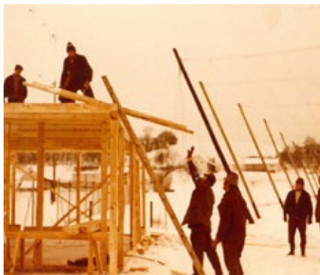
Januar 1973: Hebauf des ehemaligen Gerätehäuschen (hier steht heute der Anbau)
