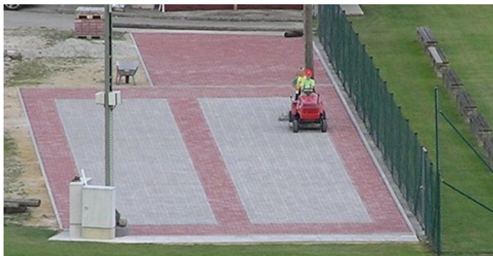
Bau der Stockbahnen im Sommer 2008
